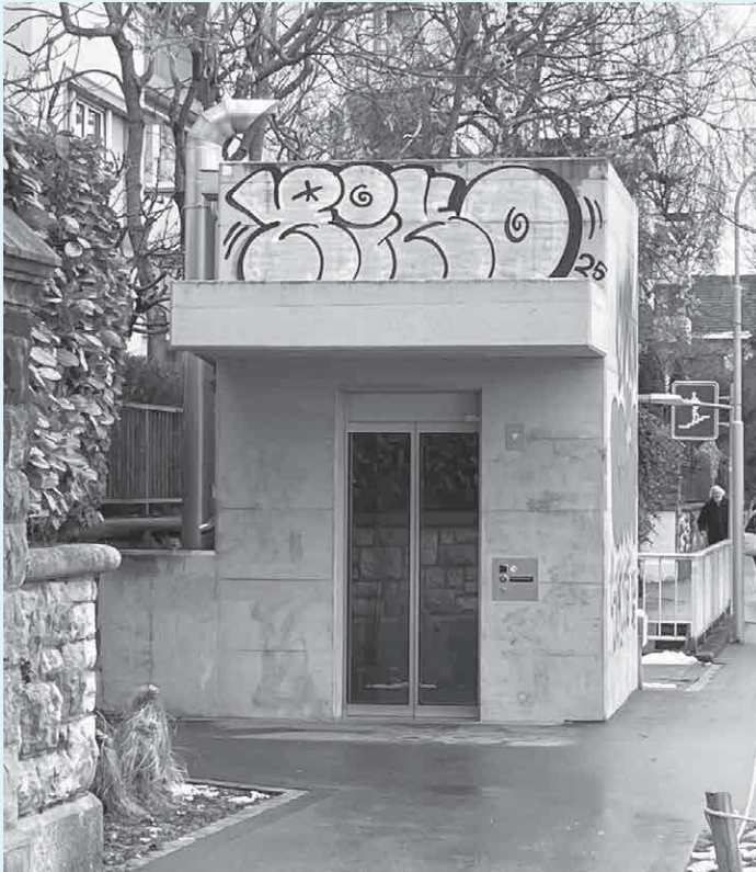
SBB Aufzugsanlage, Foto: Franz Bartl
