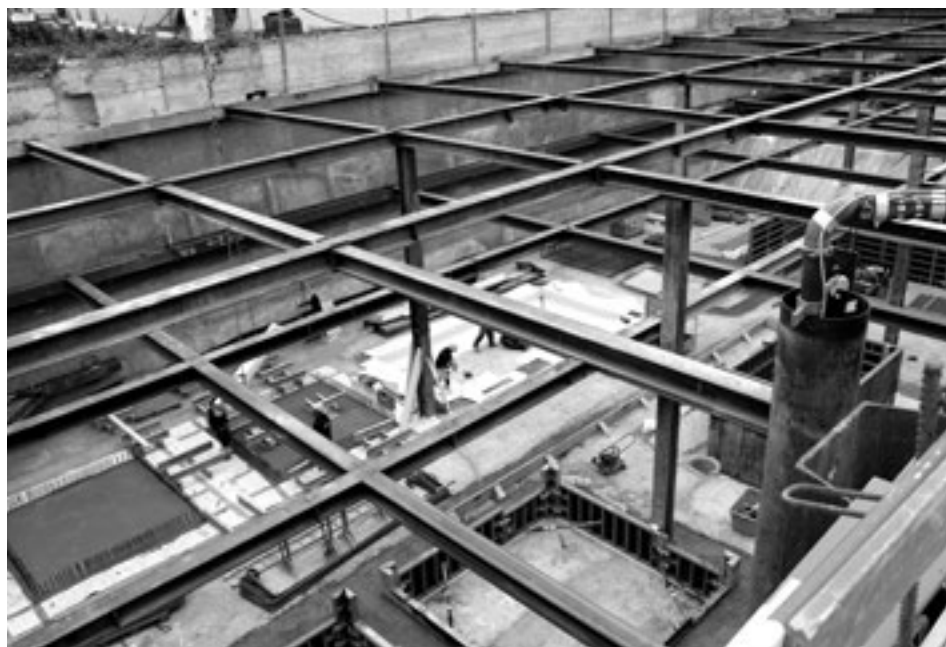
Was man später nicht mehr sieht: Viel Tiefbau unter neuen Wohnhäusern an der Alderstrasse. Foto: Adolf Gucker, 2015
