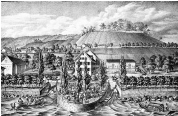
Gast- & Gesellschaftshaus der Gebrüder Unholz «zum Tiefen Brunnen» an der neuen Seestrasse, bei Zürich ca. 1840*
