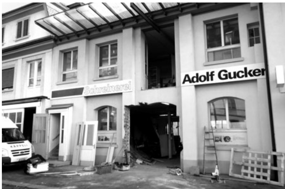
Die ehemalige Schreinerei Gucker an der Alderstrasse – der Abbruch ist schon im Gang – (oben) und das an Stelle des Gewerbegebäudes kürzlich fertiggestellte Mehrfamilienhaus (unten)
