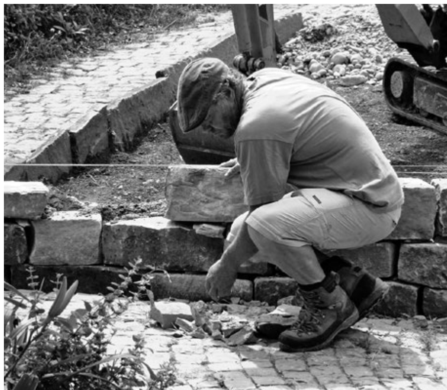
Eugen Ofner beim Setzen der Steine der Trockenmauer.
