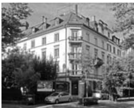
Dufourstrasse 138, Foto AV
