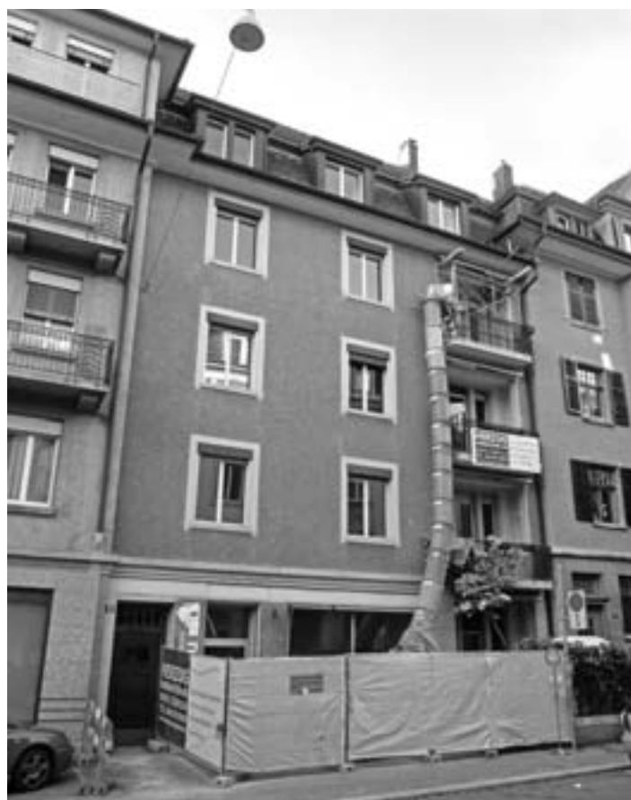
Das Haus Apollostrasse 3 während dem Umbau
