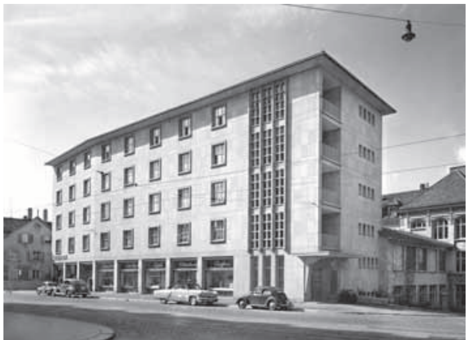
Aufnahme von 1953: Baugeschichtliches Archiv Zürich
