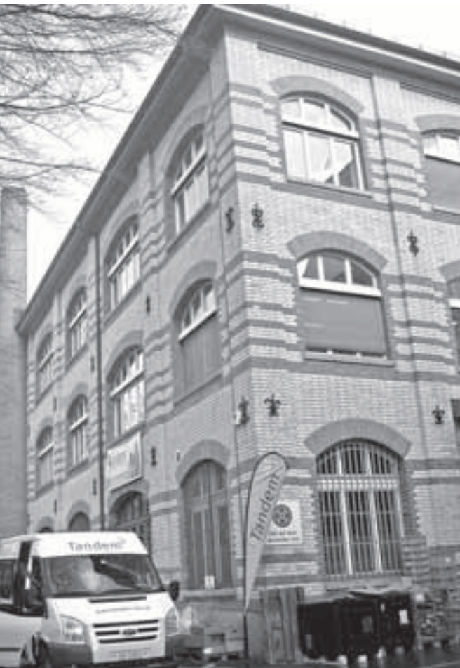
Das Fabrikgebäude Seefeldstrasse 119, im Hinterhof von Haus Nr. 111, stammt aus dem Jahr 1895 und ist im kommunalen Inventar der Denkmalpflege verzeichnet. Charakteristisch sind das zweifarbene Sichtbacksteinmauerwerk und der hohe Kamin sowie die Eisenanker, die auch als Bauschmuck dienen. Das Gebäude wurde als «Velociped-Fabrik» erbaut und 1911-13 im Auftrag des Lithografen J.C. Müller erweitert und aufgestockt. Die Druckerei, Kunstanstalt J.C. Müller, hatte sich schon früh der Produktion von grossflächigen Plakaten verschrieben und war lange Jahre im Gebäude ansässig, bevor die Firma nach Schlieren verlegt wurde. GA
