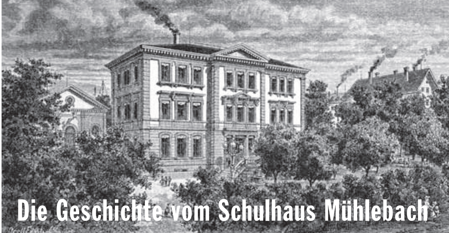
Schulhaus am Mühlebach, Abbildung aus der Chronik der Kirchgemeinde Neumünster 1889
