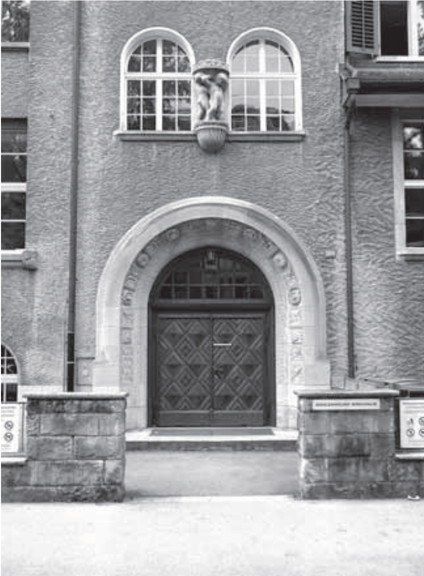
Schulhaus Münchhalde, Fotos Tom Hebbing
