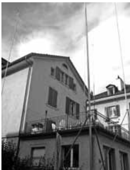
Bauliche Veränderungen an der Reinhardstrasse
