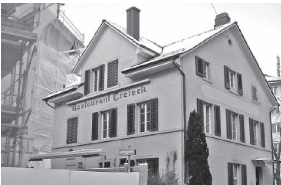
«Bei der unteren Brücke» in Riesbach war die Leimsiederei im Adressbuch von 1867 verzeichnet, das Wohnhaus mit heutigem Restaurant Freieck entstand 1870.
