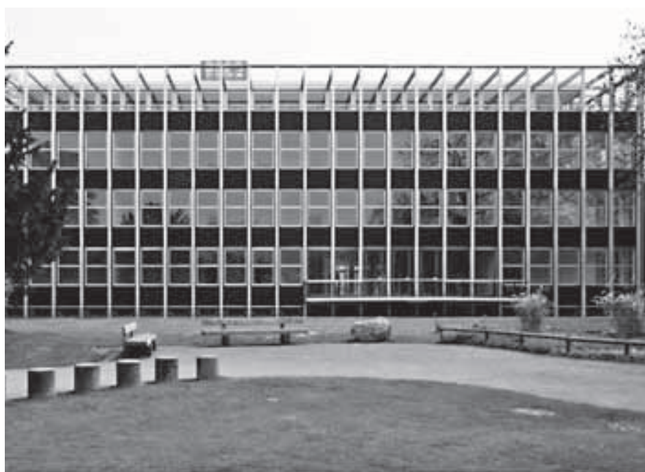
Abb. 2. Das ehemalige Verwaltungsgebäude Alusuisse ist in jeder Beziehung ein Kind seiner Zeit, also ein wichtiger Zeuge im Sinne des Denkmalschutzes, Foto Beatrice Lang, BAZ
