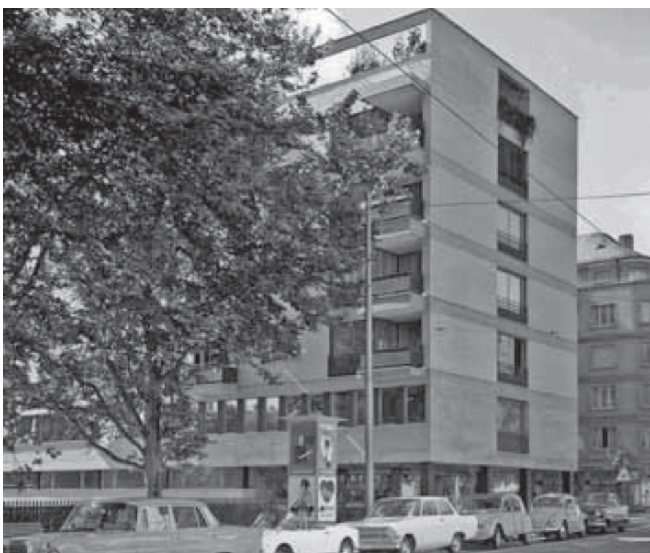
Abb. 1. Das Haus von Architekt Jakob Zweifel an der Spielweise: Ob es zur Zeit seiner Erstellung als «schön» angesehen wurde? Unterdessen ist es jedenfalls ein Schutzobjekt! Foto Fritz Maurer 1961
