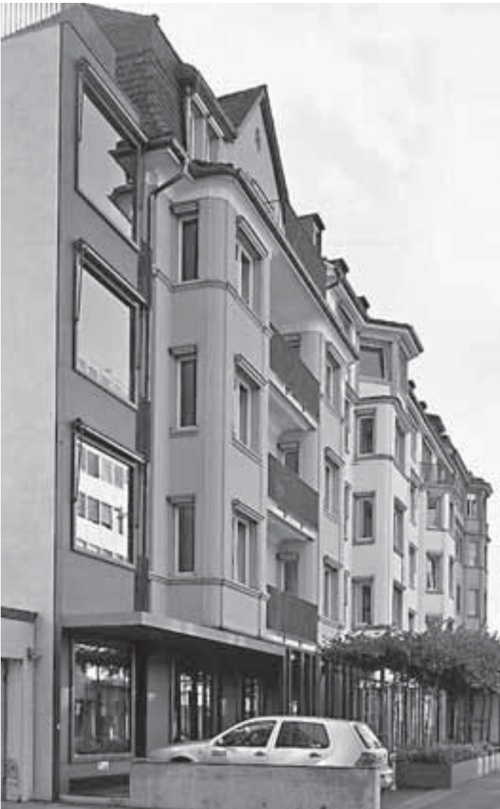
Abb. 4. Der komplett sanierte und erweiterte Bürokomplex an der Mühlebachstrasse. Bild MS
