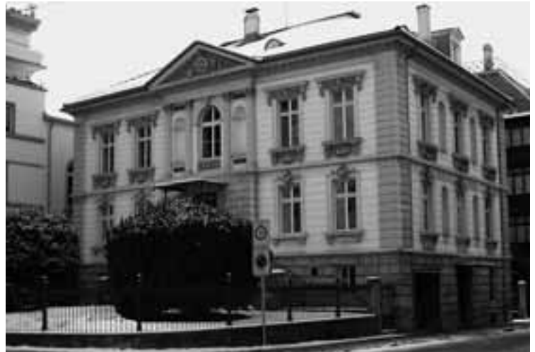
Ehemaliges Atelier, Magazin und Wohnhaus Hörbst Ecke Klausstrasse. Foto Hans Oberholzer
