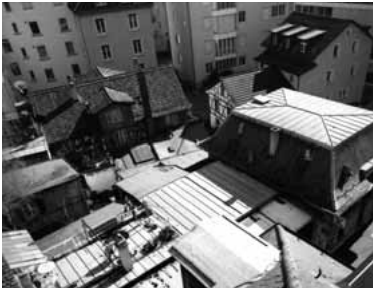
Dachlandschaft im Geviert Seefeldstrasse/Werkgasse. Hier entstehen die neuen Alterswohnungen. Foto BAZ 1986
