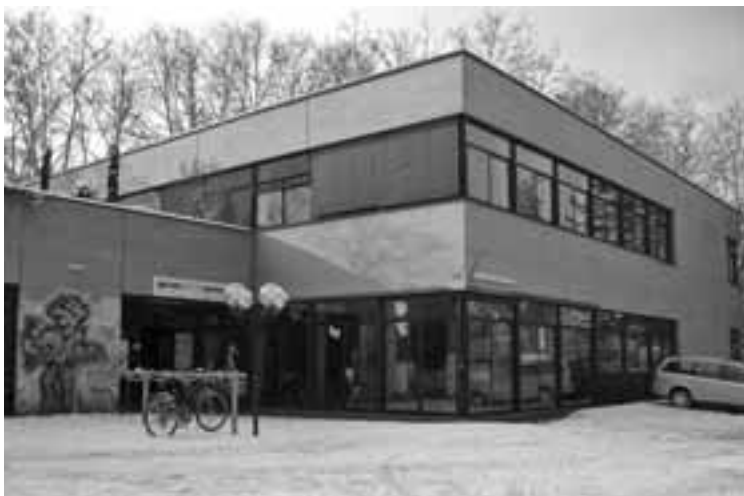
GZ Riesbach, Seefeldstrasse 93. Foto Hans Oberholzer
