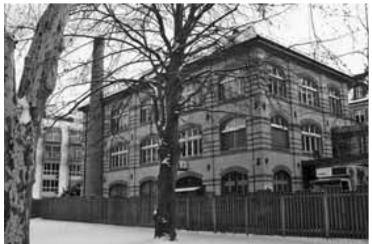
Das 1895 erbaute Fabrikgebäude Seefeldstrasse 119. Foto Hans Oberholzer
