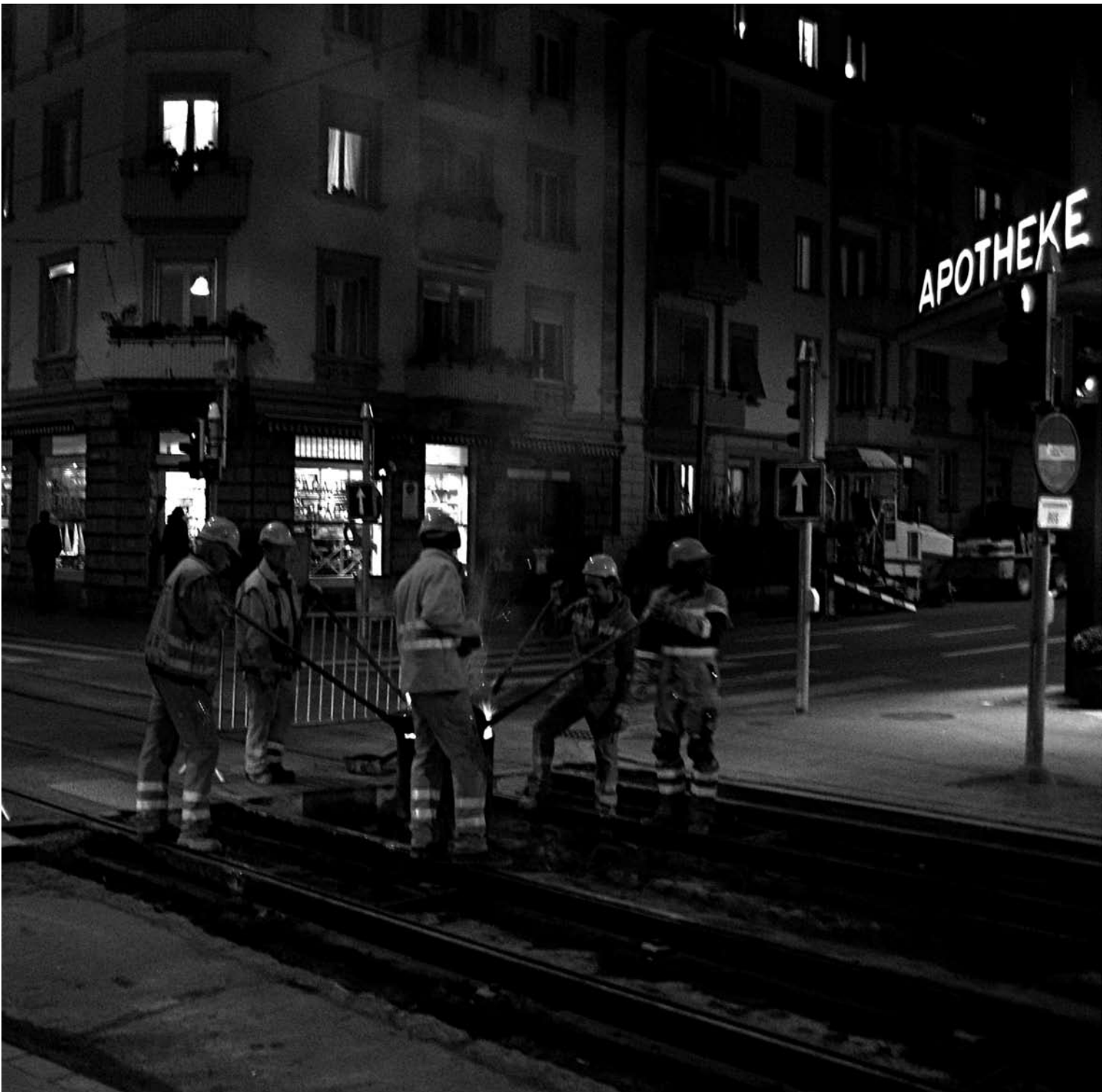
November 2007: Mitternächtliches Werk auf der Seefeldstrasse – Gleisarbeiter verflüssigen in einem Fass Bitumen als Gleisunterguss (Bild Katharina Issler)
