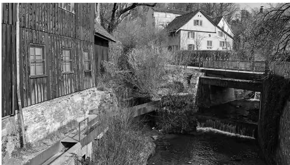
Bei der Burgwies führt der Oberwasserkanal (der rostige Kännel in der linken Bildhälfte) das Wasser des Wehrenbachs (von rechts) über den Stöckentobelbach (Bildmitte) unter der Forchstrasse hindurch zur Mühle Hirslanden. Foto: Daniel Wehrli
